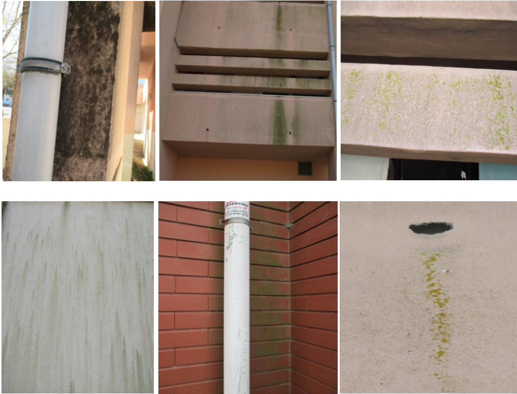
Figura 2.13. Exemplos de fixação de fungos (à esquerda), algas (ao centro) e líquenes (à direita)
