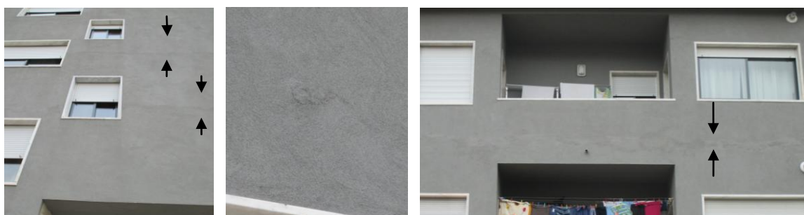
Figura 2.20. Deficiência de planeza com distinção de desníveis horizontais na superfície (imagem à esquerda) e irregularidades superficiais (imagem ao centro e à direita)
