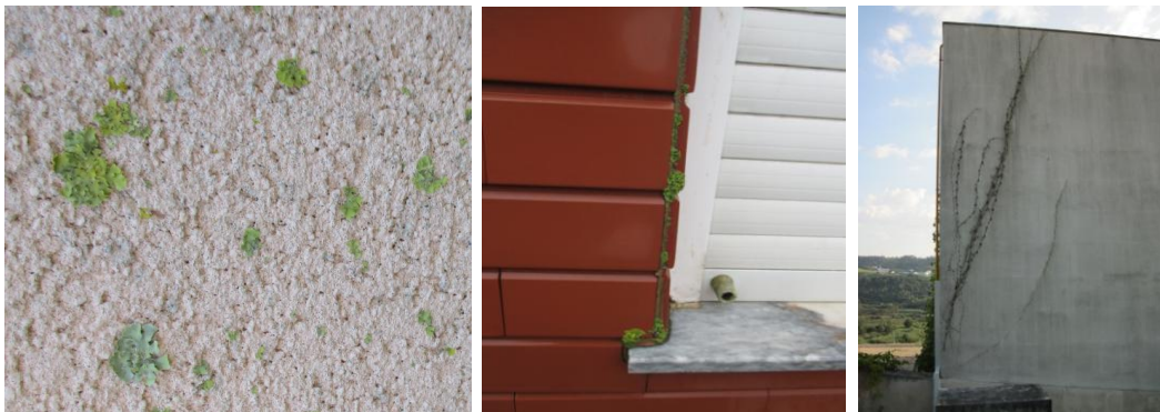
Figura 2.13. Exemplos de fixação de fungos (à esquerda), algas (ao centro) e líquenes (à direita)
