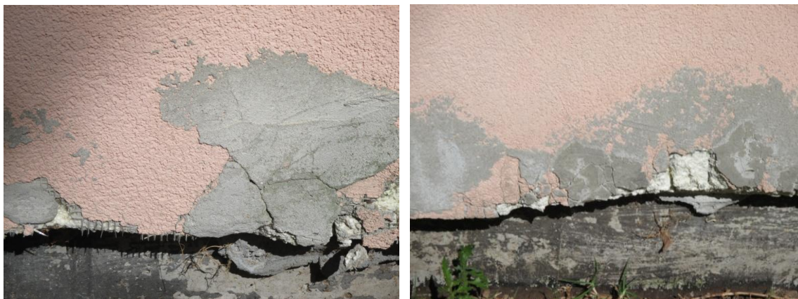
Figura 3.26. Tentativa de reparação dos revestimentos afectados
