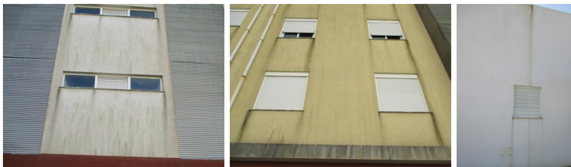
Figura 2.10. Exemplos de anomalias do tipo escorrências
