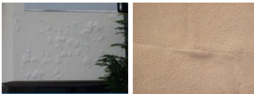
Figura 2.18. Exemplos de empolamentos (imagem à esquerda da autoria de MOREIRA et al. , 2015)
