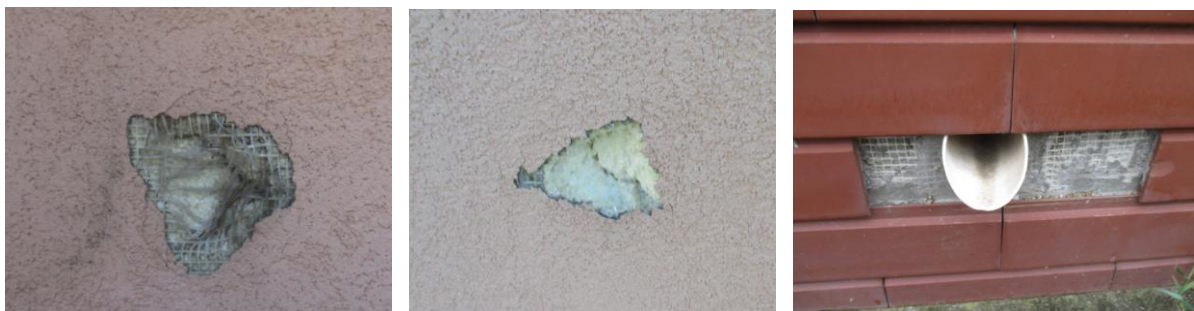
Figura 2.6. Lacuna de material até ao nível da placa isolante (à esquerda e ao centro) e lacuna de material até ao nível da armadura num sistema cerâmico (à direita)
